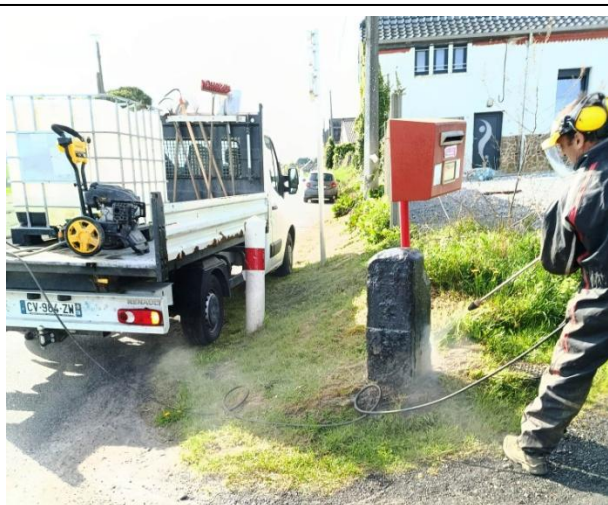
Nettoyage de la borne n° 17 au Kärcher thermique.
