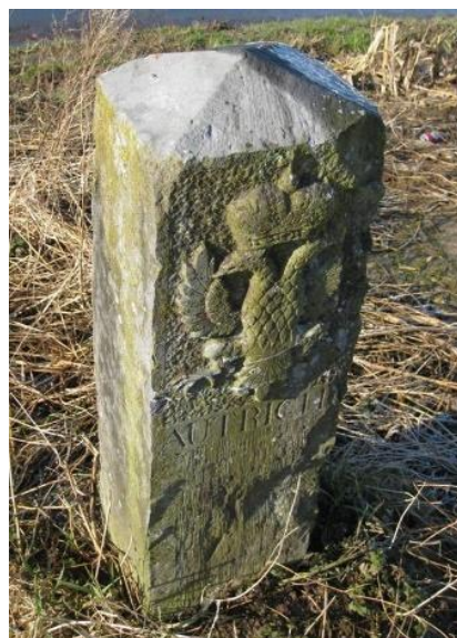
Fig. 7. Les bornes-frontières placées à La Flamengrie diffèrent des bornes plus simples qu'on trouve ailleurs sur la frontière 24 ; elles sont en pierre bleue de la région, avec une section carrée d'environ 28 cm de côté et une hauteur d'environ 150 cm (dont la moitié enterrée) ; deux faces sont sculptées avec, d'un côté un aigle bicéphale avec l'inscription « AUTRICHE », de l'autre trois fleurs de lys et l'inscription « FRANCE » et sur le dessus un numéro d'ordre allant de 1 à 65.
