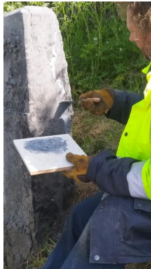
Application de colle à deux composants sur la borne n° 52
