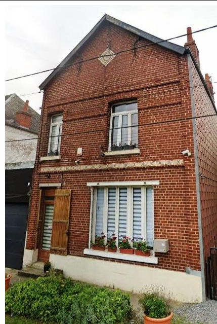
L’ancien Bureau de Douane du Poste des Chefs (devenu une habitation)
