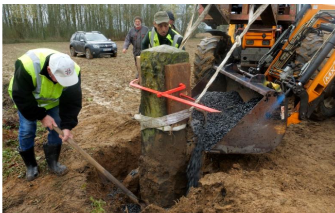
La borne n° 63 est redressée et calée avec des cailloux
