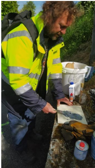
Préparation de la colle à deux composants
