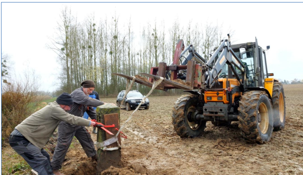
Redressement de la borne frontière n° 63 à la limite de Bettrechies et de Honnelles.
