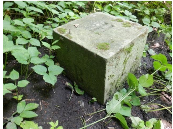
Les bornes placées en 1901 entre Roisin et Gussignies portent un F du côté France, un B du côté belge et, sur le dessus, une lettre (A, E, H, I, J ou K) correspondant aux plans de modification de la frontière établis ... en 1893.
