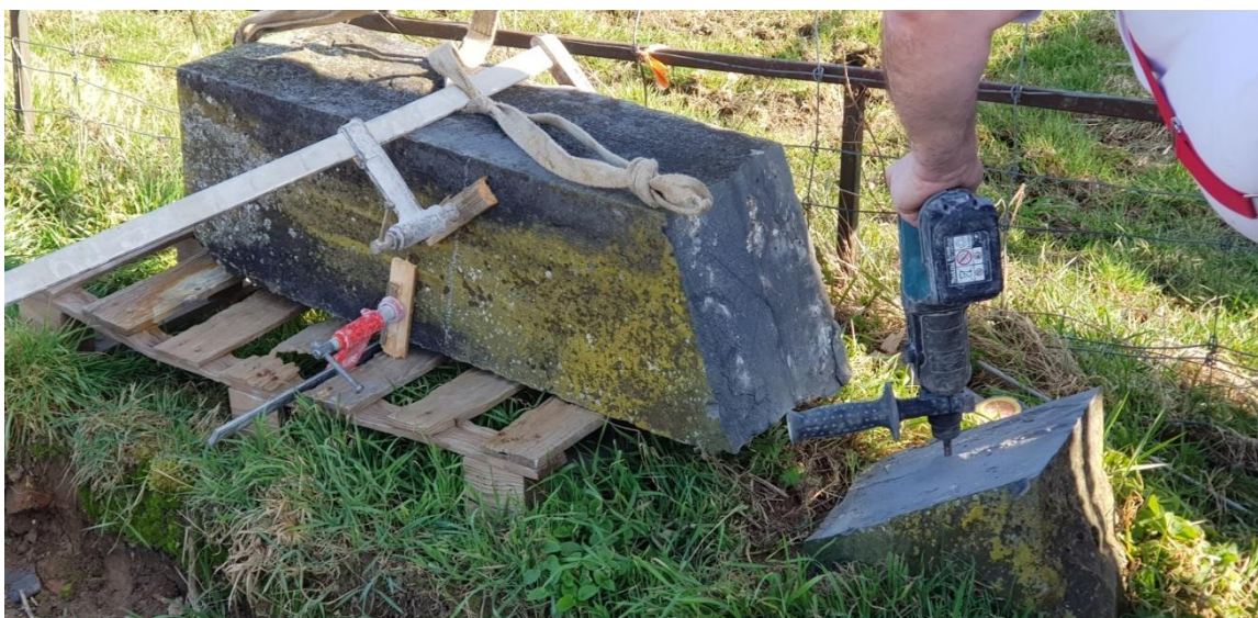
La borne n° 38 en cours de réparation en 2020.
