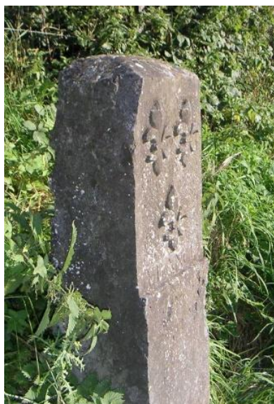
Fig. 7. Les bornes-frontières placées à La Flamengrie diffèrent des bornes plus simples qu'on trouve ailleurs sur la frontière 24 ; elles sont en pierre bleue de la région, avec une section carrée d'environ 28 cm de côté et une hauteur d'environ 150 cm (dont la moitié enterrée) ; deux faces sont sculptées avec, d'un côté un aigle bicéphale avec l'inscription « AUTRICHE », de l'autre trois fleurs de lys et l'inscription « FRANCE » et sur le dessus un numéro d'ordre allant de 1 à 65.
