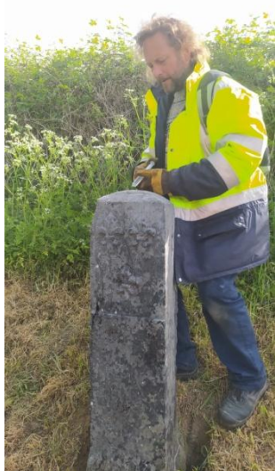
Injection de colle liquide dans les fissures de la borne n° 52
