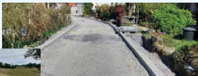
Pose des éléments linéaires et de la sous-fondation.
