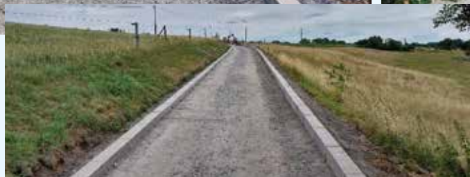
Réalisation des zones de trottoirs en pavés béton.
