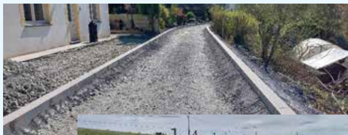
Pose des éléments linéaires et de la sous-fondation.
